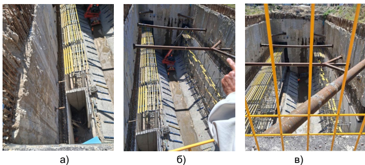
Фиг. 5.10. Анкериращи глави на ненапрегнати IBO анкери по подпирашка стена на дълбок изкоп - места за монтаж на силомерите между анкерната глава и опорната плоча: а) общ изглед на изкопа и подпирашката стена; б) анкериращи глави и разпонни подпори; в) изглед към изкопа (оригинални снимки на автора; снимките са от строителен обект на Софийския метрополитен и илюстрират технологията на укрепване, приложена при разглежданите в монографията обекти)
