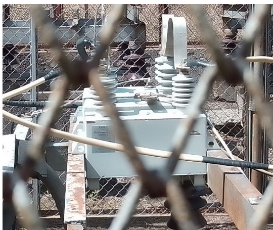
Фиг. 4. Монтаж на кондензаторните батерии
