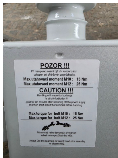
Фиг. 10. Табела на кондензаторните елементи
