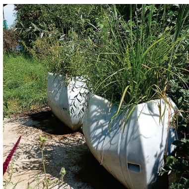
Фигура 55. Конструираната влажна зона с интегрирани седиментни микробни горивни клетки след едногодишна работа
