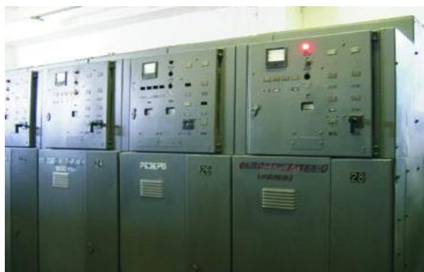
Фиг. 1. Външен вид на КРУ преди реконструкция
