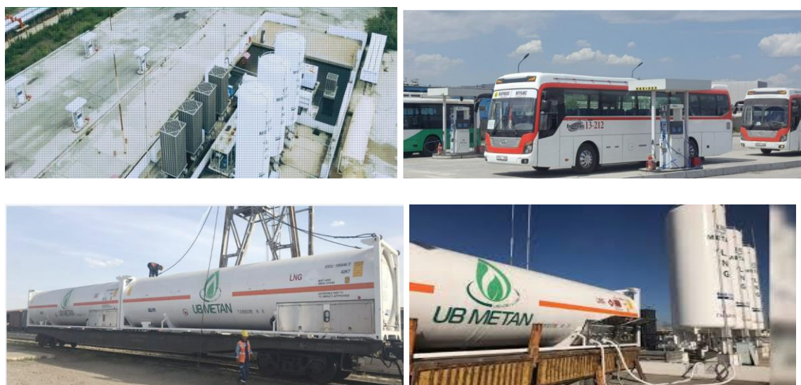
Фиг. 2.6 LNG-CNG станция на "UB methane" ООД
