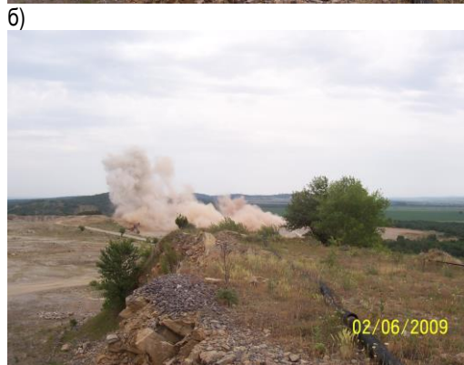
Фиг. 6. Газо-прахови емисии от взривяване по технология без преудълбаване. В лявата част с въздушно-физичен взрив, а в дясната с хидро-физичен взрив
