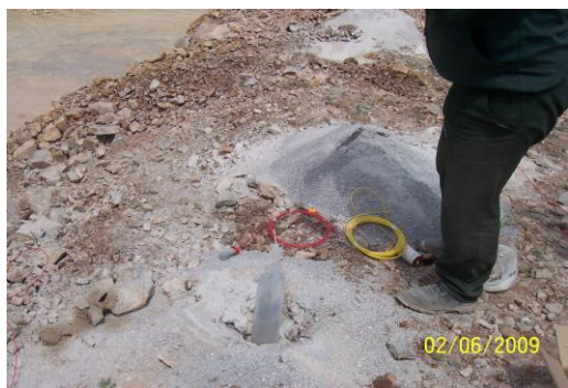
Фиг. 5. Фрагменти от изграждането на незаредената част с воден патрон и начина на поставянето му
