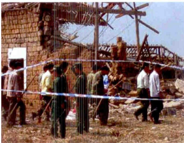
Фиг. 6 Фрагменти от разрушенията след експлозия на автомобил с 19,5 тона амониев нитрат в Shengangzhai, Китай
