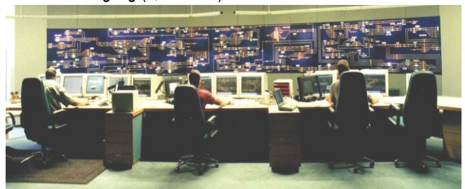
Abb. 9 Leitstand des zentralen Eisenbahnbetriebes im elektronischen Zentralstellwerk
