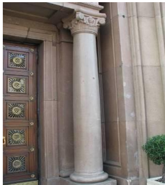
Фиг. 1. Дебелостенни облицовки на външните стени и цоклите на сгради в централната част на столицата, Министерския съвет
