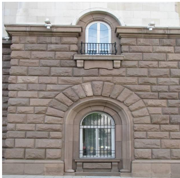
Фиг. 1. Дебелостенни облицовки на външните стени и цоклите на сгради в централната част на столицата, Министерския съвет
