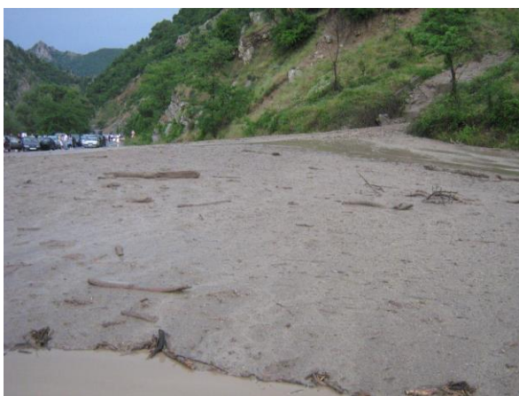
Фиг. 8. Разлив от преовлажнен материал
