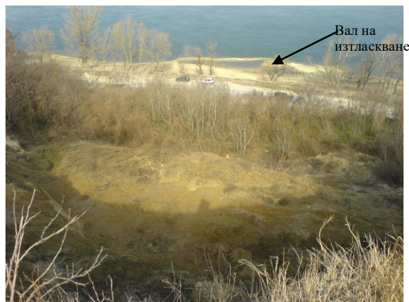
Фиг. 3. Глава и вал на изтласкване на свлачището
