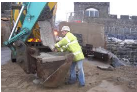
Сн. 9. Полагане на бетонна смес директно от транспортното средство
