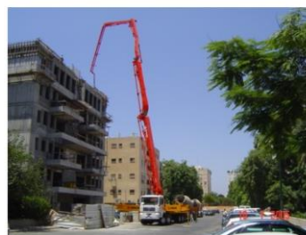
Сн. 10. Бетон - помпи
