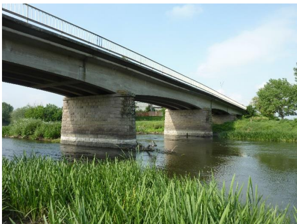
Фиг. 2. Изглед към мостовото съоръжение
