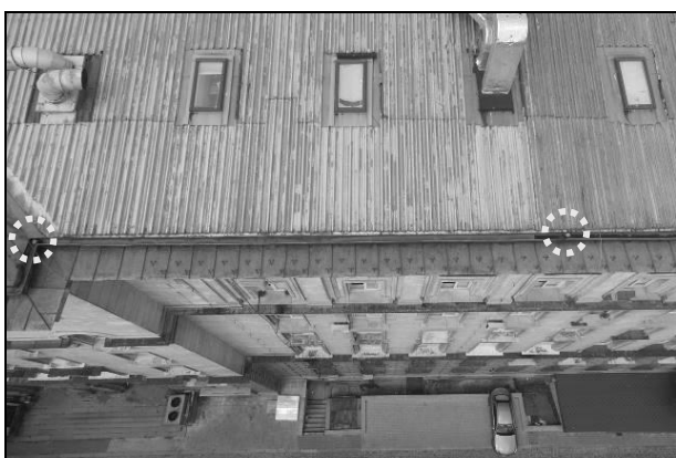
Фиг. 6. Участък от покрива на северното крило на сградата на Президентството, с локализираните местата на два от водостоците
