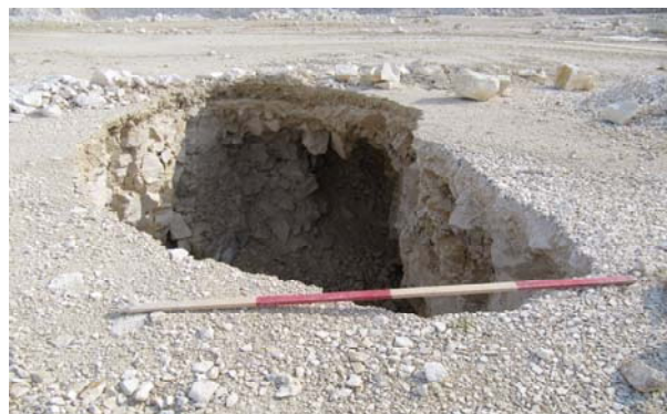
Фиг. 7. Развитие на каверна без запълнител по карстова система при т. 323 в северния борд на хор. 145.
