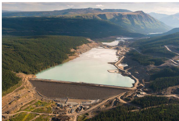
Фиг. 3. Долинен тип конвенционално отпадъкохранилище, меднопорфирно находище Highland Valley, Британска Колумбия, Канада ( https://www-tailings )
