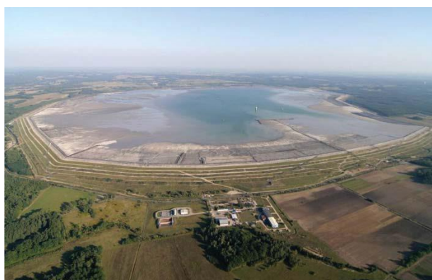
Фиг. 2. Равнинен тип конвенционално отпадъкохранилище, медно находище Железни Мост (Zelazny Most), Полша
