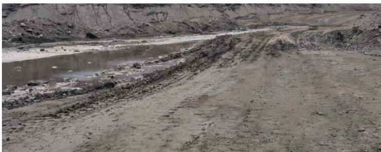
Снимка 1.4 Рудничен път с неподдържана дренажна система
