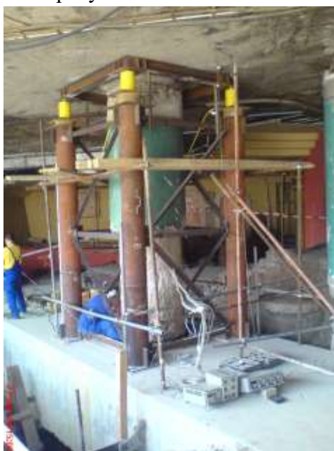
Фиг.4.64: Изпълнена конструкция на премостване с монтирана крикова инсталация за временно подпиране на подлеза
