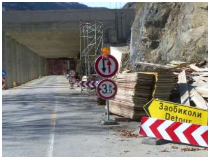
Фиг.9.7: Котражна конструкция и изпълнено премостване преди свързване със съществуващата стена
