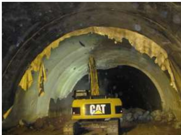
Фиг.6.9: Етапи от разбиването на опасната третична облицовка в дясната тръба на тунел „Витиня” и полагането на нова хидроизолация.
