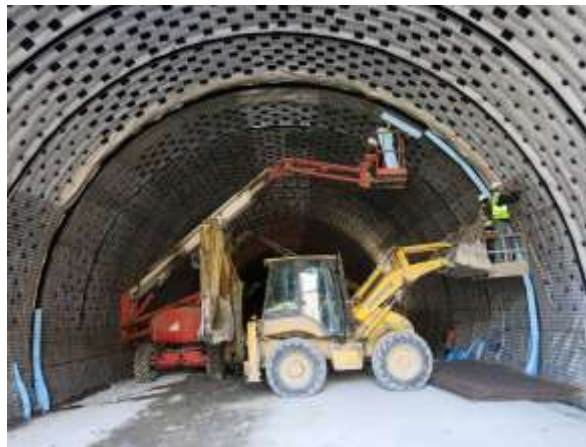
Фиг.6.9: Етапи от разбиването на опасната третична облицовка в дясната тръба на тунел „Витиня” и полагането на нова хидроизолация.
