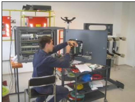
Фиг. 4 Конструкция на релейен отсек с вторична комутация
