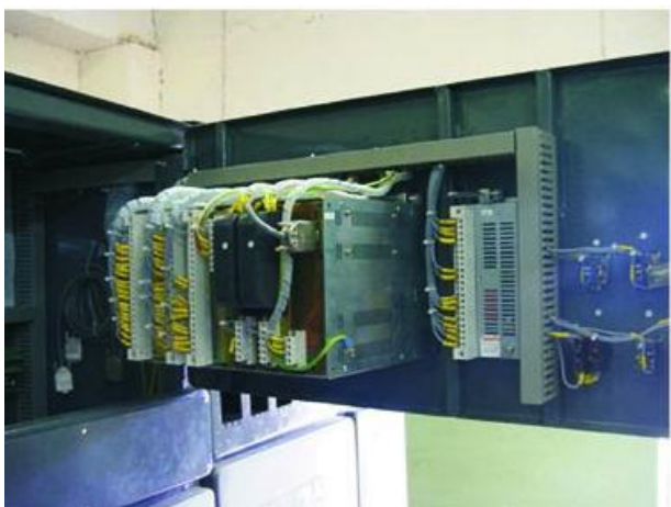
Фиг. 4. Релеен отсек на КРУ след реконструкция
