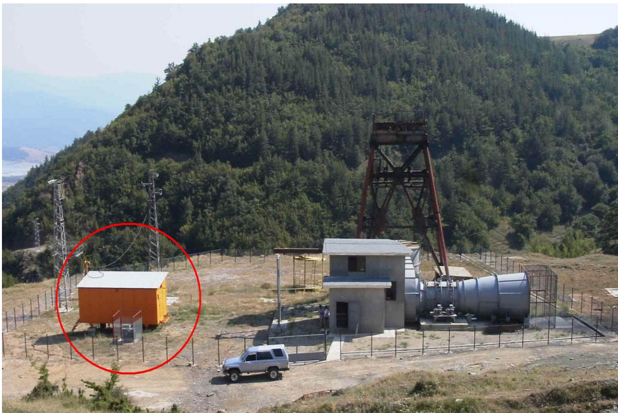
Фиг. 1. Комплетна преносима електрическа уредба (заградена в кръга) за управление на вентилаторна уредба – шахта “Север”, Челопеч Майнинг
