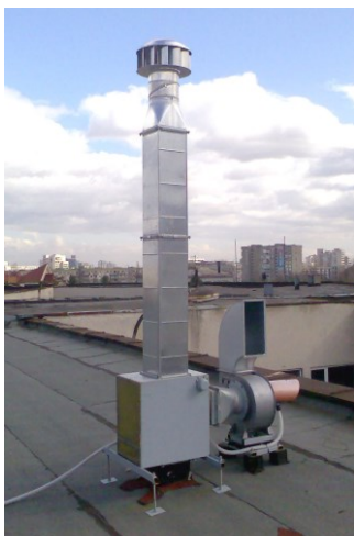
Фигура 6.23 Хибридна схема на вентилация
