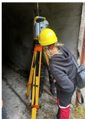
Фиг. 4. Координиране на точки от полигонов ход
