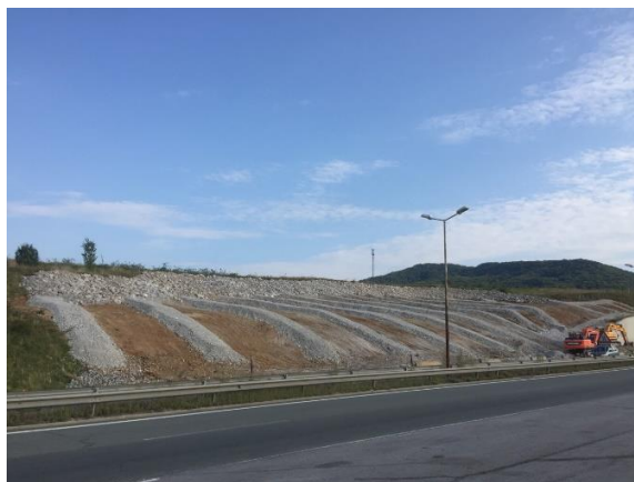
Фиг. 1.7: Изглед на оребряването и заскаляването преди залесяване между ребрата на АМ“Струма“ км.7+160
