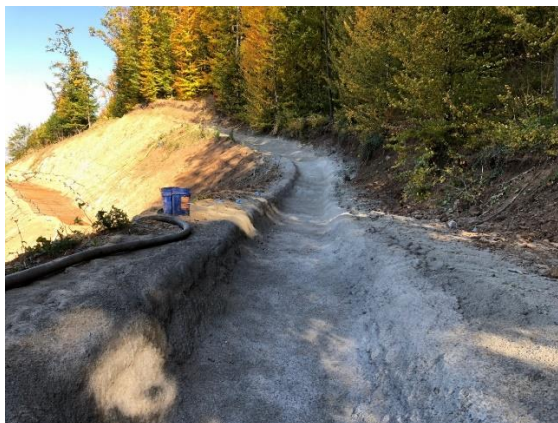
Фиг. 1.4: Предпазна канавка с плътна облицовка от пръскан бетон по грабена на откоса на km.9+750 на АМ „Струма“
