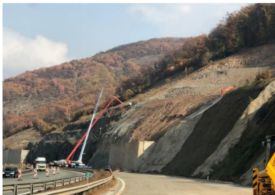
Фиг.1.2: Аварийно-възстановителни работи на откоса при 9+750 на АМ“Струма”- ляво платно
