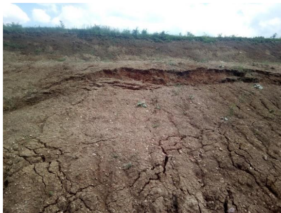
Фиг. 1.6: Поредно свличане и изтичане на земни маси върху платното на АМ "Струма" km.7+160
