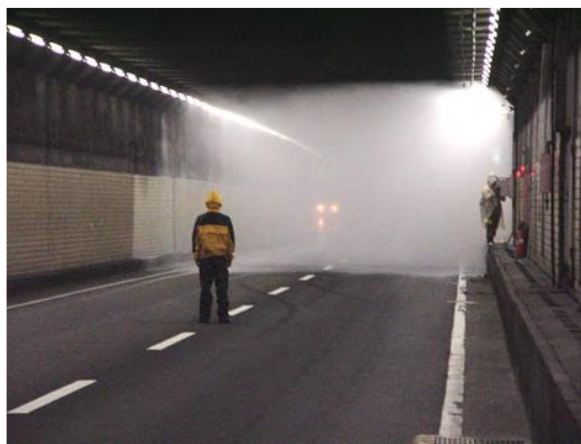
Фиг. 13. Система за водна мъгла в японски тунел
