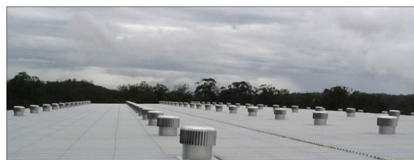
Фиг.1. Пример за използване на ветровентилатори
