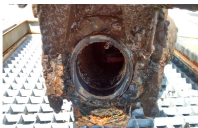
Фиг. 1. Метални детайли обхваната от обща корозия
