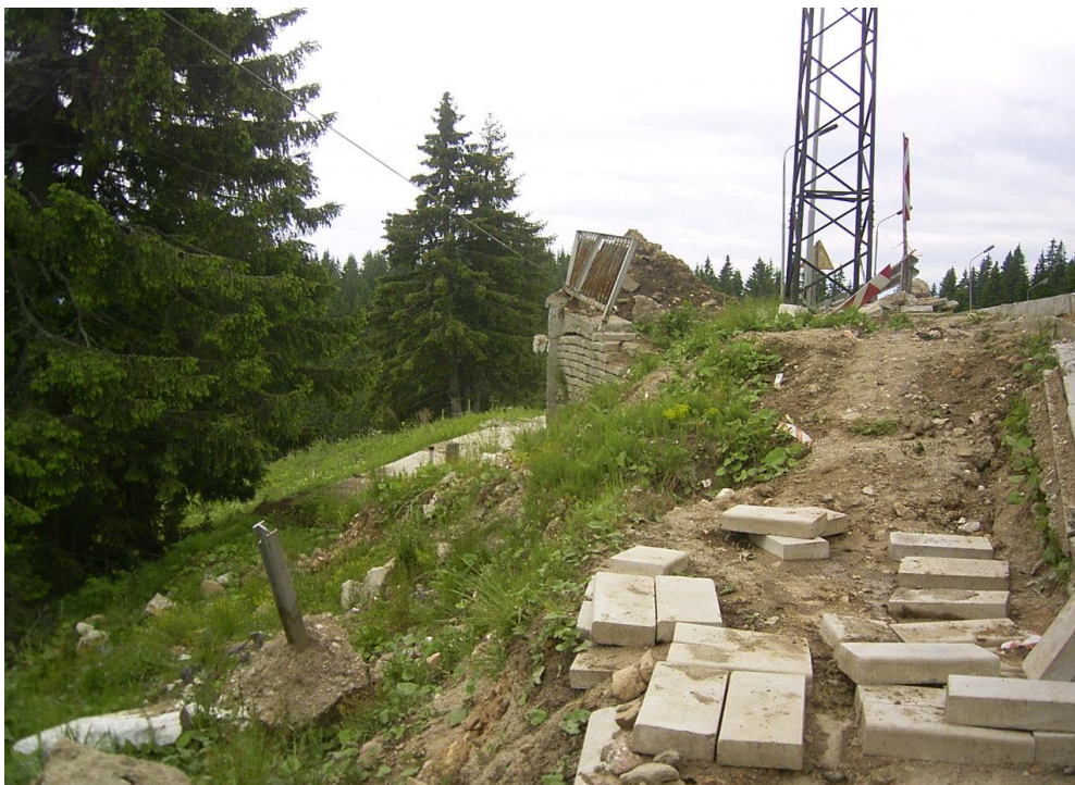
Сн. 3. "Новоизтекло" свлачище в съседен, устойчив домоментата участък
