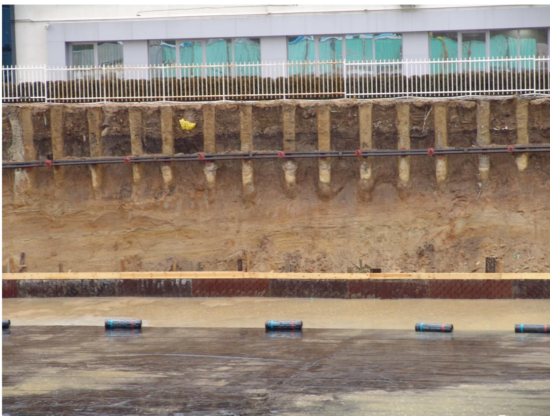
Сн. 2. 170 броя пилоти с диаметър 30 см и дължина 10,5, подпрени през два метра с къси микро пилоти на обединителна греда
