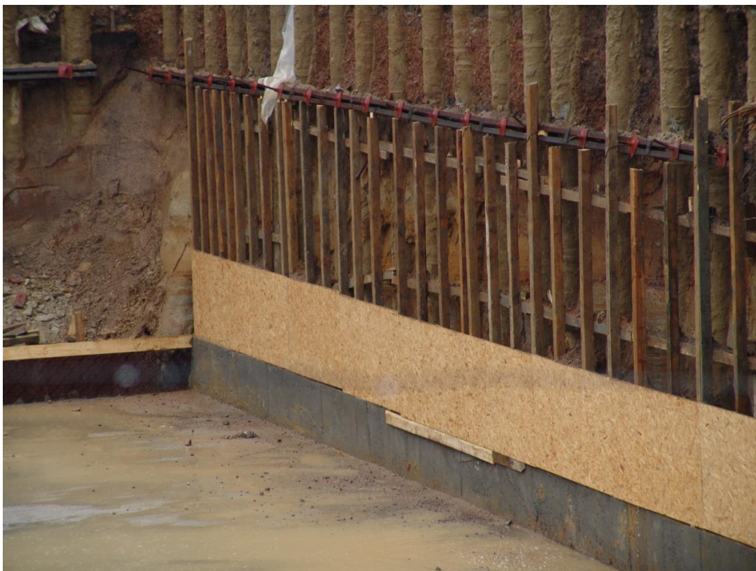
Сн.1. Технологично четиристранно укрепване на изкоп с дълбочина 7 м. 500 000 лв се прибавят само към перо изкопни работи, без да имат отношение към сигурността на бъдещата сграда.
