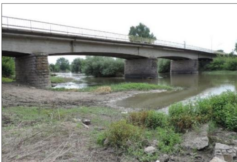
Фиг. 4.2.1. Мостът над р. Тунджа в гр. Елхово, свързващ града със с. Изгрев
