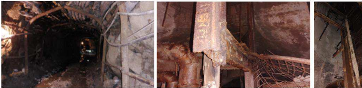
Фигура 4.1 Корозирали стоманени елементи в подземни съоръжения
