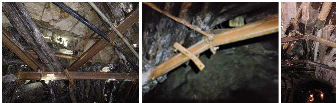
Фигура 1.1 Влияние на корозията върху подземните метални крепежни елементи
