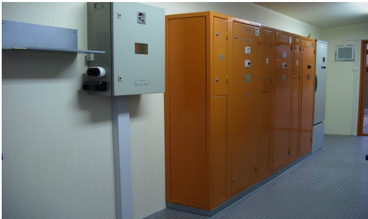
Фиг. 4. Електрическа уредба НН
