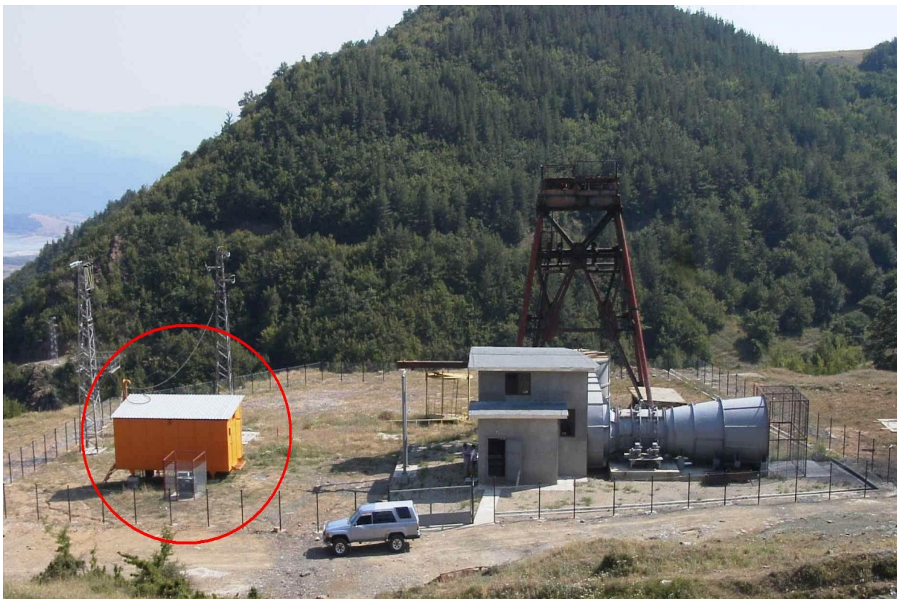
Фиг. 1. Комплектна преносима електрическа уредба (заградена в кръга) за управление на вентилаторна уредба – шахта “Север”, Челопеч Майнинг
