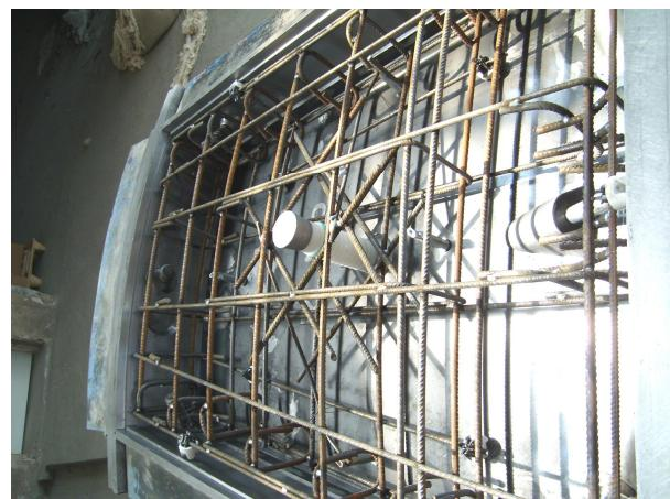
Фиг. 3. Подготвен за бетониране сегмент – с монтирани и фиксирали армировъчен скелет и елементи за вграждане
