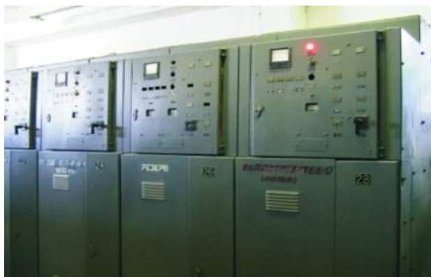
Фиг. 1. Външен вид на КРУ преди реконструкция
