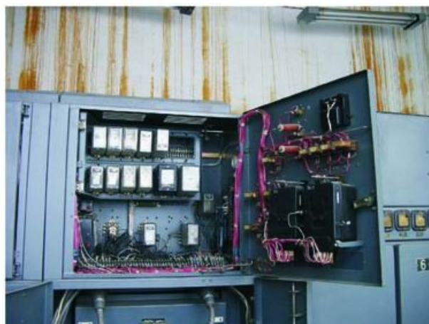
Фиг. 2. Релеен отсек на КРУ преди реконструкция
