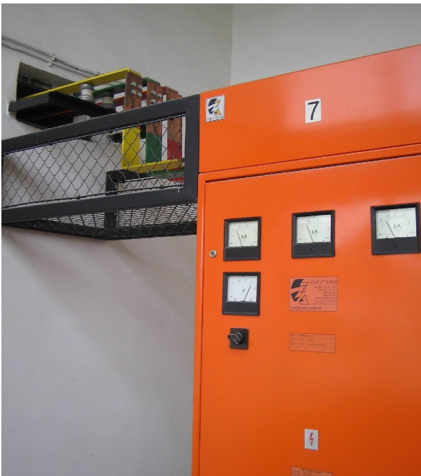
Фиг.5. Главно табло НН след реконструкция на Подстанция "Руднична" в Челопеч Майнинг.
