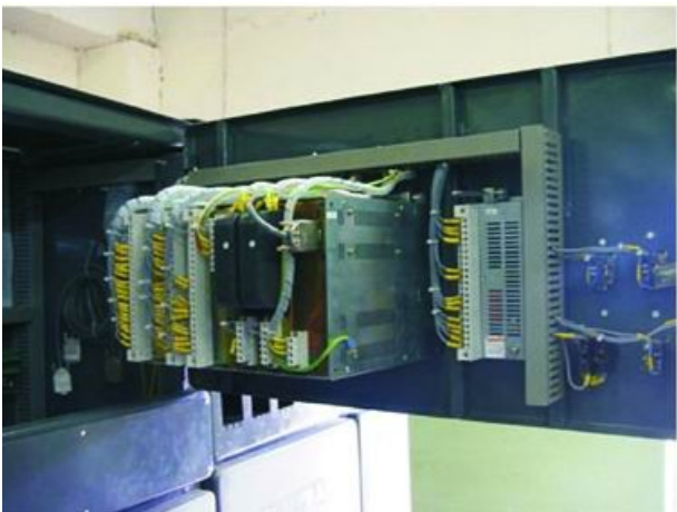
Фиг. 4. Релеен отсек на KPU след реконструкция
