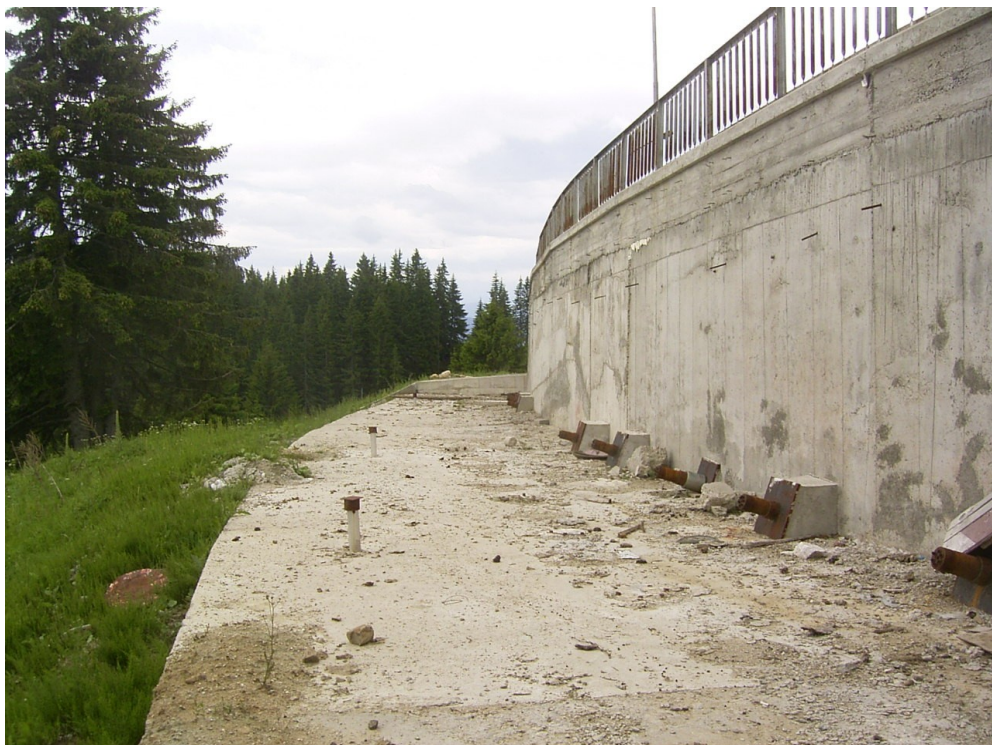
Сн. 4. Укрепената част от свлачището с опорна стена анкеризирана с тежки (800kN), предварително напрегнати анкери
