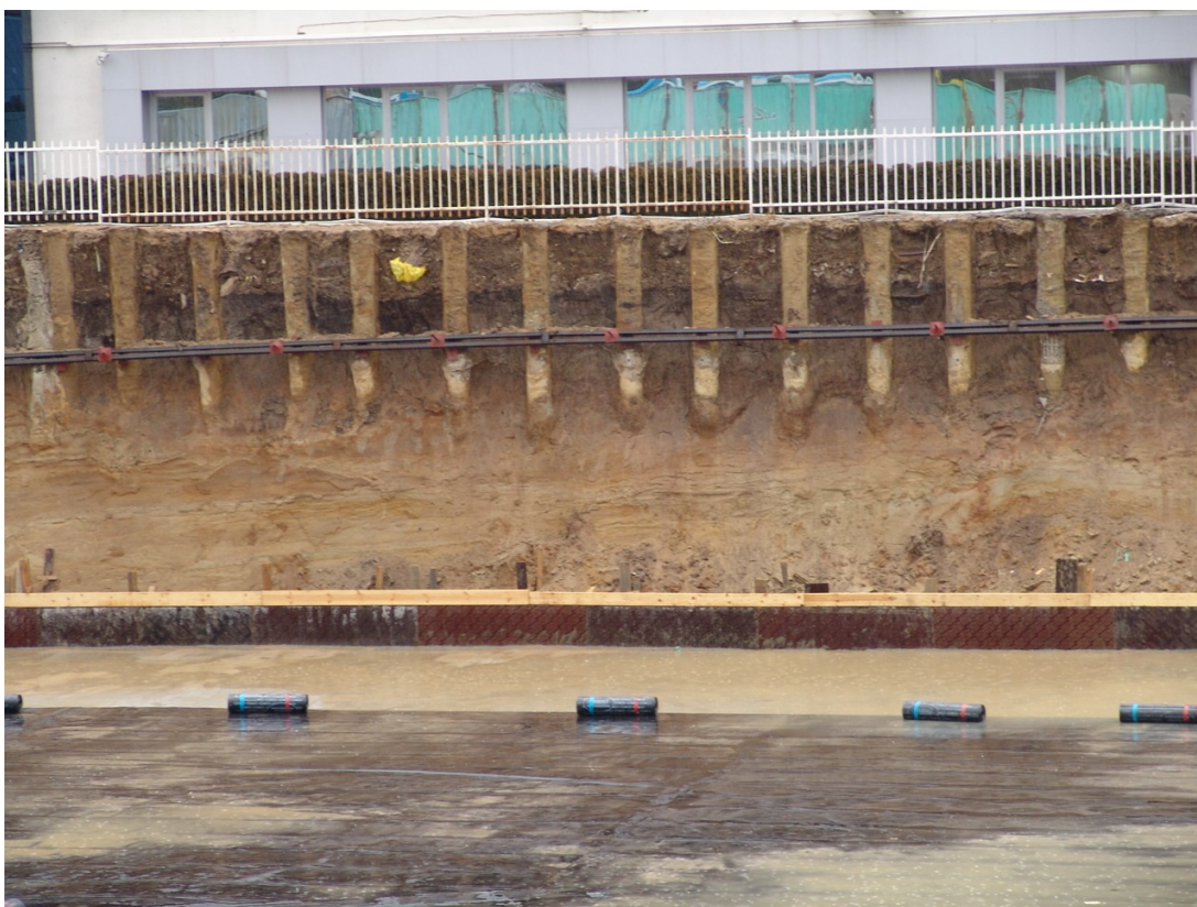
Сн. 2. 170 броя пилоти с диаметър 30 см и дължина 10,5, подпрени през два метра с къси микро пилоти на обединителна греда Защо се спираме толкова подробно на този въпрос? градове, където геологията е най-подробно проучвана и Подземни етажи, паркинги гаражи се строят в големите често има архивни данни от стари сондажи, но до каква
