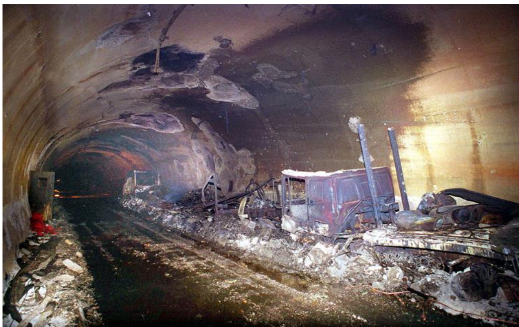
Фигура 3. Изглед на пораженията след пожара в тунел „Мон Блан“
