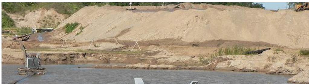
Фиг.1. Намивно поле при работа със земснаряд
