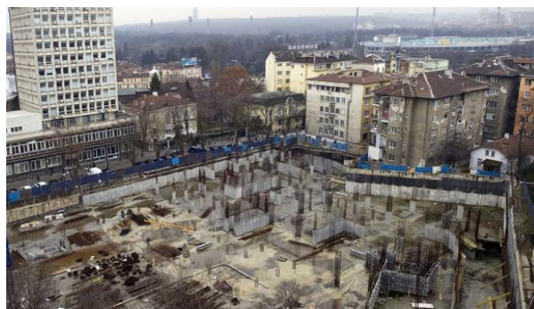
Сн. 3. „Сан Стефано плаза“ с изкоп близо 19 м дълбок с площ 6,5 дка
