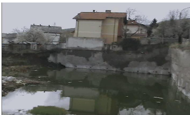
Сн.1. Укрепване с торкрет и анкери-обектът е спрял на етап укрепен откос преди 2 години
