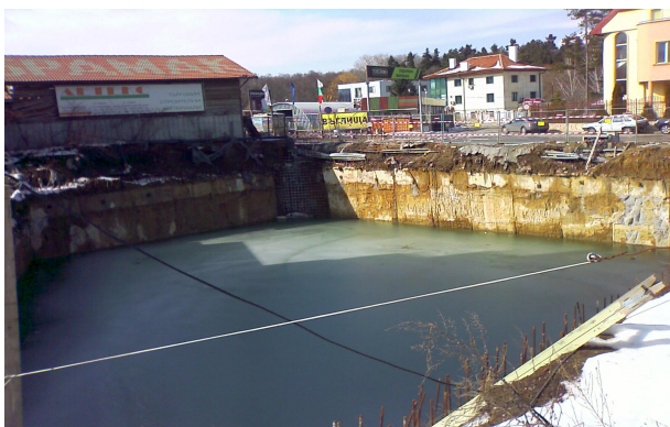
Сн.2. Укрепване със шлицови стени и пасивни анкери
