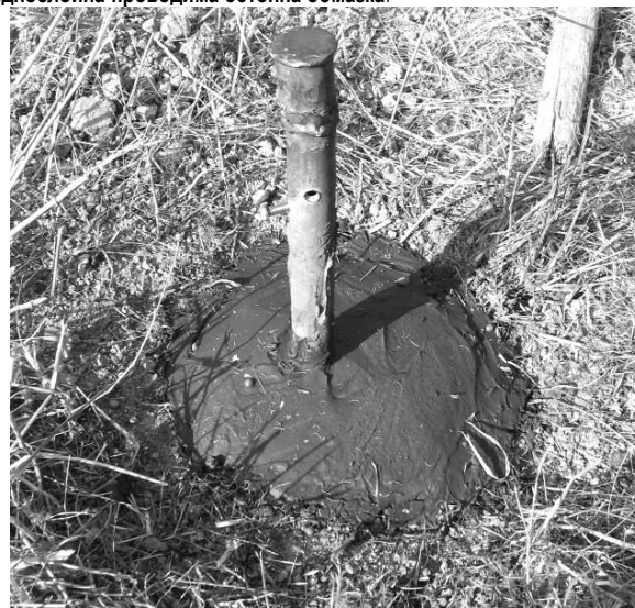
П. 2. Външен вид на вертикален заземител с еднослойна проводима бетонна обmazка.
