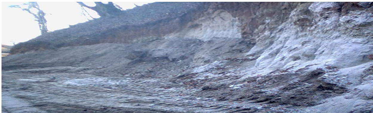
Сн. 1. Общ вид на изкопите след прокарване на тръбопровода
